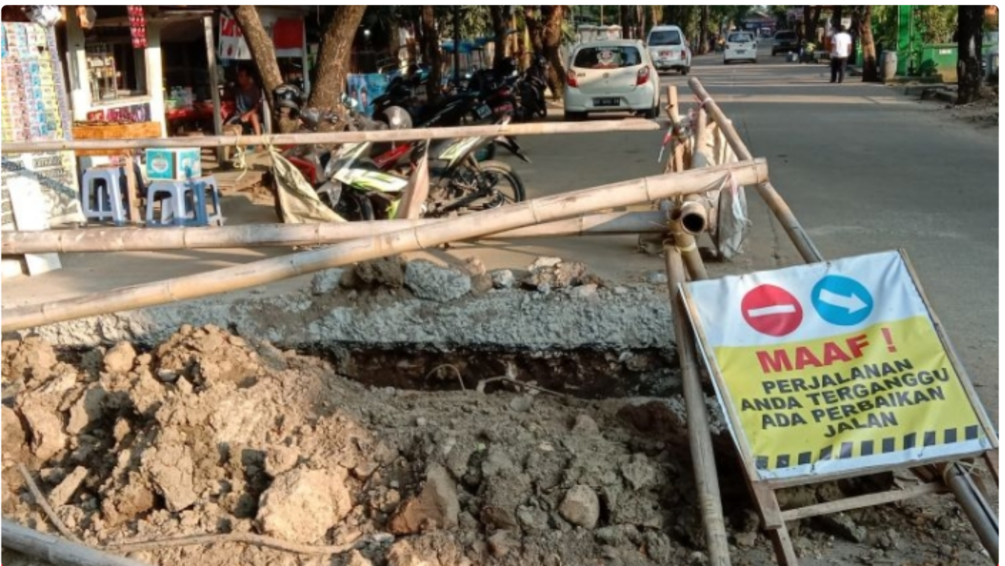
Jalan Cendana dibongkar dan belum dilanjutkan pekerjaannya
